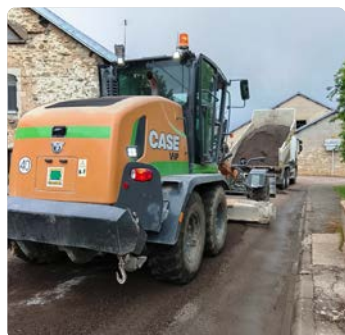
A Aujourres, lundi 11 mai, les travaux ont commencé très tôt le matin.
